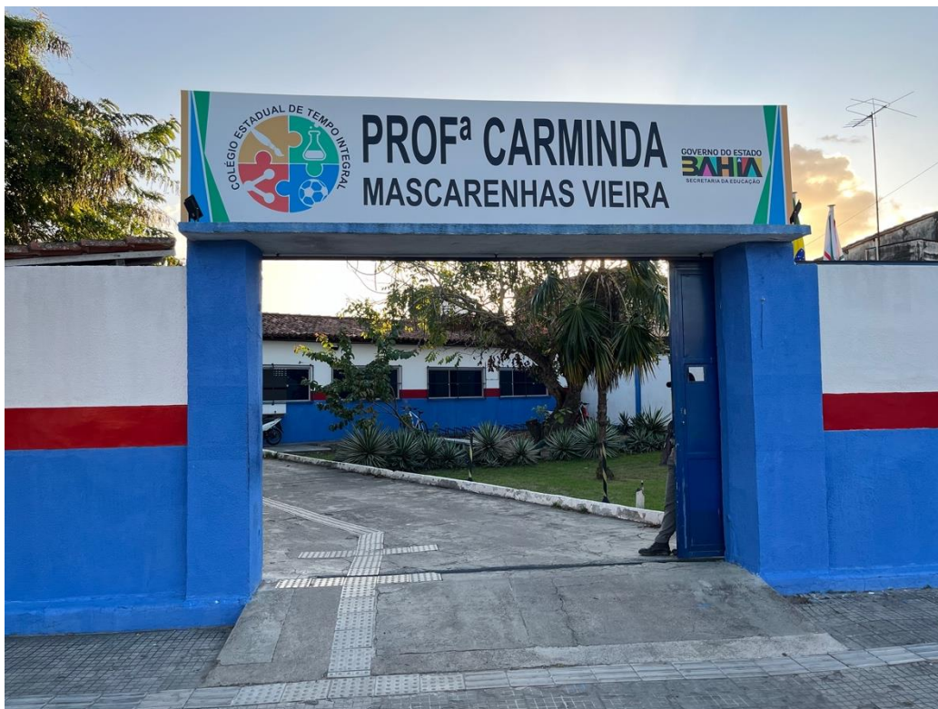
Foto 01 - Portão de entrada
