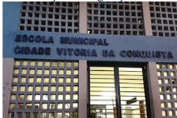
Figura 2: Fachada da escola após reconstrução e inauguração, em 2006
