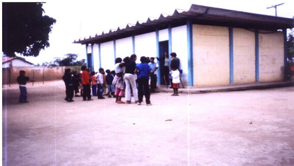
Foto 1 – Prédio da Escola Ana Gomes
